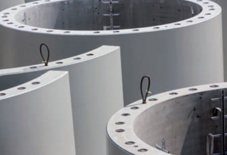
LAGERUNG DER TURMSEGMENTE | DETAILANSICHT EISENBINDEN
