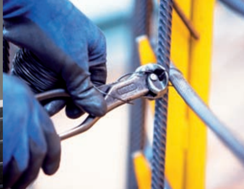
LAGERUNG DER TURMSEGMENTE | DETAILANSICHT EISENBINDEN
