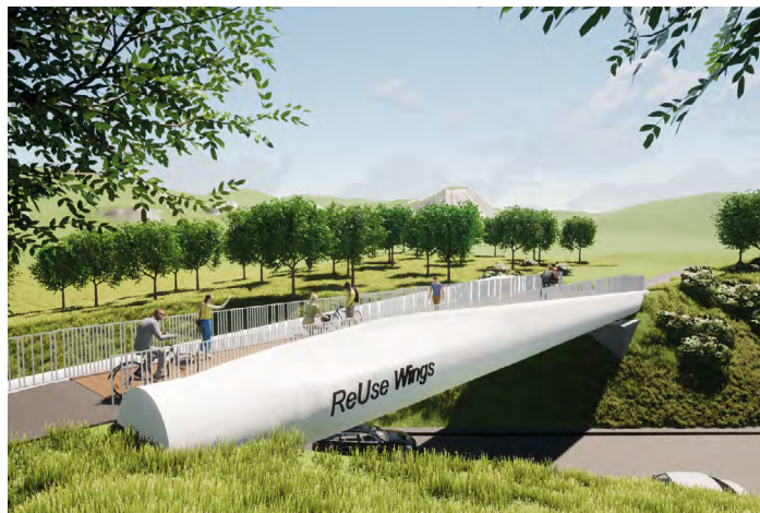
Re-Use: Flügel aus Windrädern als Brückengeländer
